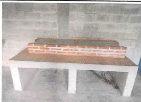
Foto 7: La estufa rural ha quedado totalmente renovada y como se comparte con la escuela primaria, se ha decidido colocar una estufa doble.
