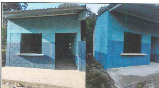
Foto 9: Se han reconstruido paredes, techo y piso de la cocina, aplicado acabados de cemento y pintado.
