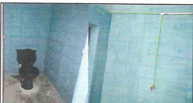
Foto 11: Los baños han sido cambiados en su totalidad, igual que el sistema de tubería para el servicio potable
