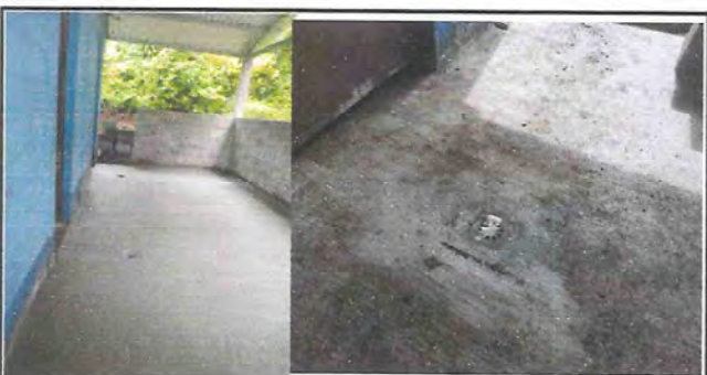
Foto 5: Se han mejorado los drenajes e instalaciones pluviales para que se distribuya correctamente el agua de lluvia y potable.
